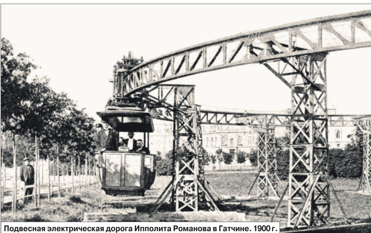
Подвесная электрическая дорога Ипполита Романова в Гатчине. 1900 г.
