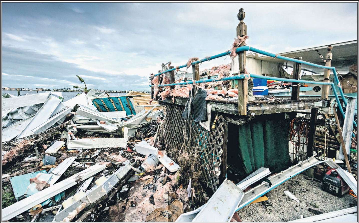
Разрушения от урагана «Милтон» в городе Брейдентон, Флорида. CRISTOBAL HERRERA-ULASHKEVICH/ EPA/TACC
