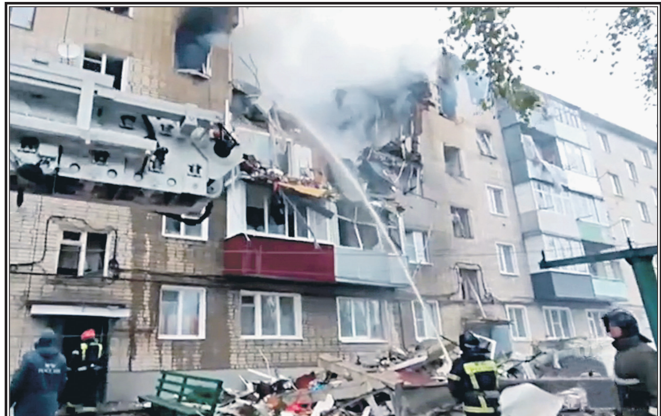
Тамбовская область. Кирсанов. Тушение пожара в результате взрыва газа в многоквартирном жилом доме на Коммунистической улице.
