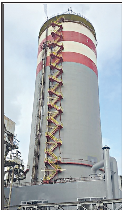
Пример двойной химии – гранбашня из железобетона с химической добавкой ЛТМ производства минеральных удобрений НРК. Автор технологии – Б.Д. Тринкер, строитель – А.Б. Тринкер.
